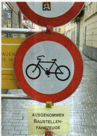
St. Pölten. Nur umweltfreundliche Schottertransporte am Lastenrad dürfen hier weiter zur Baustelle. Foto: Friedrich Wilhelm.
